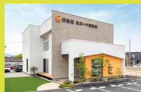
▲最新の建材や設備などが豊富にそろい、展示方法にも工夫が凝らされています。
